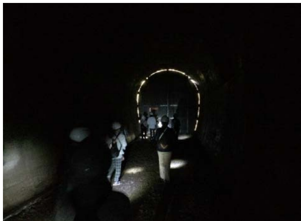
トレッキングツアー限定公開の山守トンネルでは懐中電灯を照らしながら探検気分を味わえます
