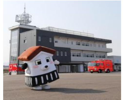
防災センター外観
